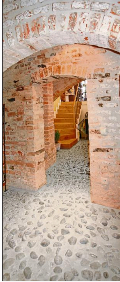
Im Keller wird die ursprüngliche Gebäudestruktur am unverputzten Mauerwerk erkennbar.
