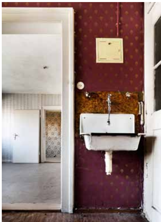
Inspirationen aus alten Zeiten: So sah die Ussar-Villa vor der Sanierung aus.
